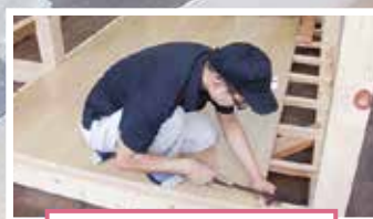
床フロア張り実習
