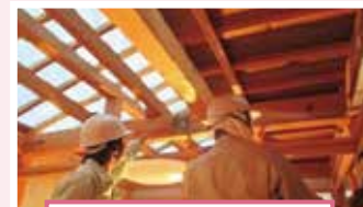
屋内配線実習
