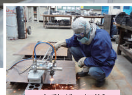
自動ガス切断
